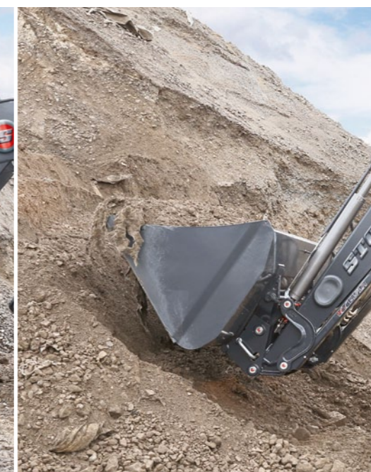
A telikanál funkciónak köszönhetően alig lép fel szivárgási veszteség.
